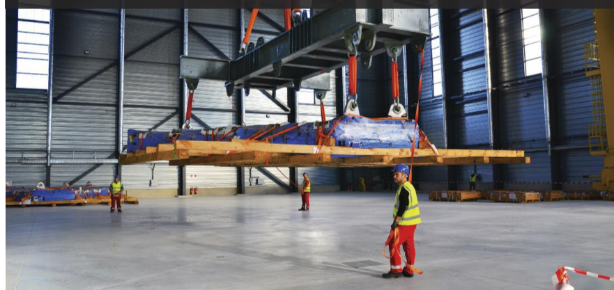
Chacun des six segments livrés pèse 50 tonnes. Il faut en assembler six, ainsi que des pièces annexes, pour former le premier niveau de la base du cryostat, l'élément le plus lourd (1 250 tonnes) de tous ceux qui seront intégrés dans la machine.
